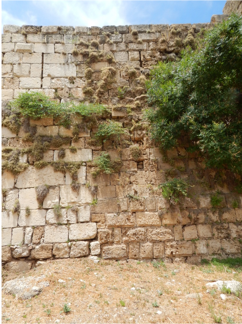
Figure 5 : Les deux murs constituant la courtine orientale du château. À noter la différence dans la technique de construction de ces deux murs : ramleh au nord et calcaire au sud (Photo : Anis Chaaya).
